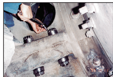
回転炉の分割ギア固定部分
